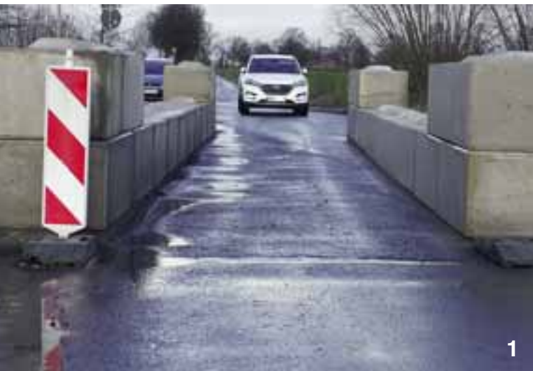
Funktioniert auch 2023 noch nicht einwandfrei: die Durchfahrtsperre vor dem Inlogparc soll die Zufahrt von LKWs und Sprintern verhindern. 1. Bild links: Die Betondurchfahrt für Fahrzeuge bis 2,20 Meter Breite. 2. Bild: Herausnehmbare Sperrpfosten für die Durchfahrt von Treckern und Feuerwehr wurden ständig entfernt. – Blickrichtung der Bilder 1-3 vom Inlogparc nach Weetfeld.
