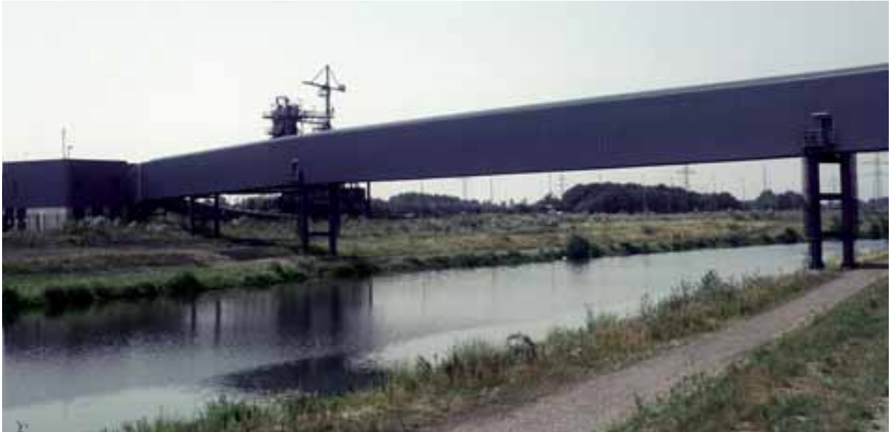
Vom Kohlehafen am Kanal hinweg über die Lippe zum Gersteinwerk erstreckte sich das Kohlenförderband für per Schiff angelieferte Kohle aus fernen Ländern. Das „Schutzgut Landschaftsbild“ fand hier keine Beachtung.
