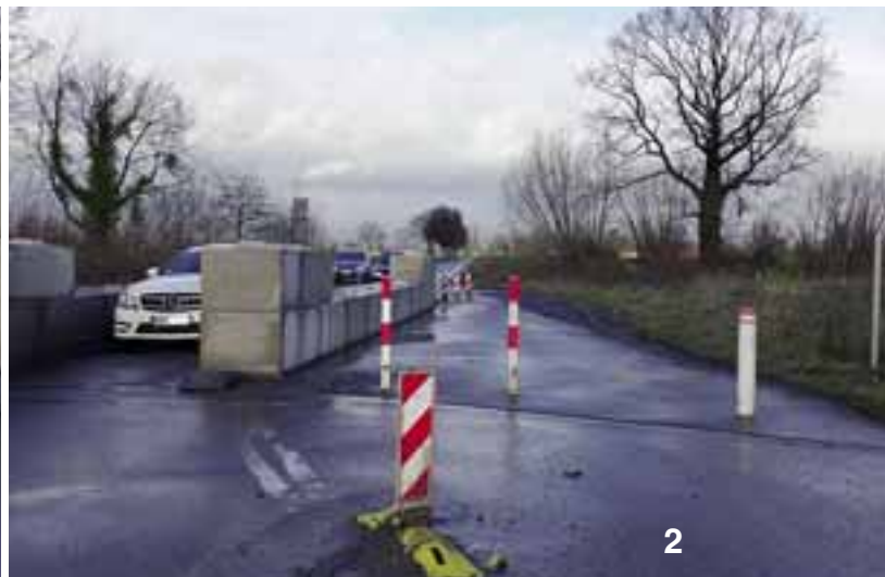
Funktioniert auch 2023 noch nicht einwandfrei: die Durchfahrtsperre vor dem Inlogparc soll die Zufahrt von LKWs und Sprintern verhindern. 1. Bild links: Die Betondurchfahrt für Fahrzeuge bis 2,20 Meter Breite. 2. Bild: Herausnehmbare Sperrpfosten für die Durchfahrt von Treckern und Feuerwehr wurden ständig entfernt. – Blickrichtung der Bilder 1-3 vom Inlogparc nach Weetfeld.
