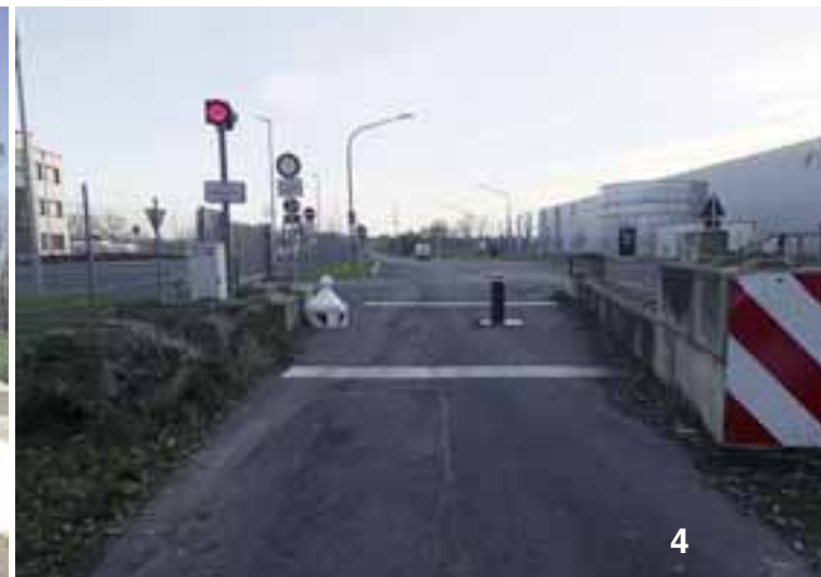
3. Bild: Der erste versenkbare Poller wurde zu Schrott gefahren, der rechte Sperrpfosten durch einen abschließbaren ersetzt. 4. Bild: Der zweite versenkbare Poller, stabiler als der erste und mit Ampelanlage versehen, kann die Durchfahrt auch nicht verhindern, der links daneben stehende Poller soll die Lücke schließen, wurde aber auch schon an die Seite geschoben. – Blickrichtung Bild 4 von Weetfeld Richtung Inlogparc, links DPD, rechts Prologis.
