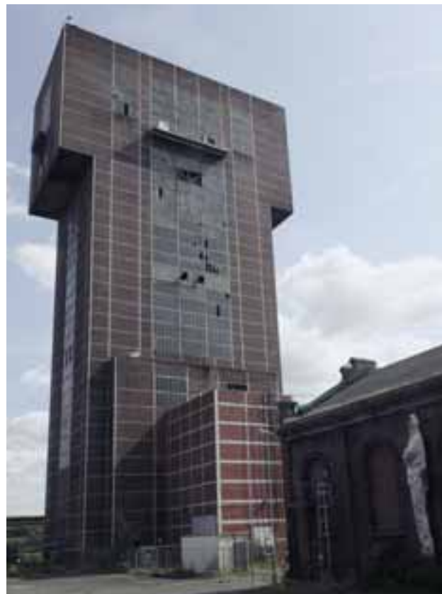
Der Hammerkopfturm ist das nach außen charakteristische Merkmal der früheren Zeche.
