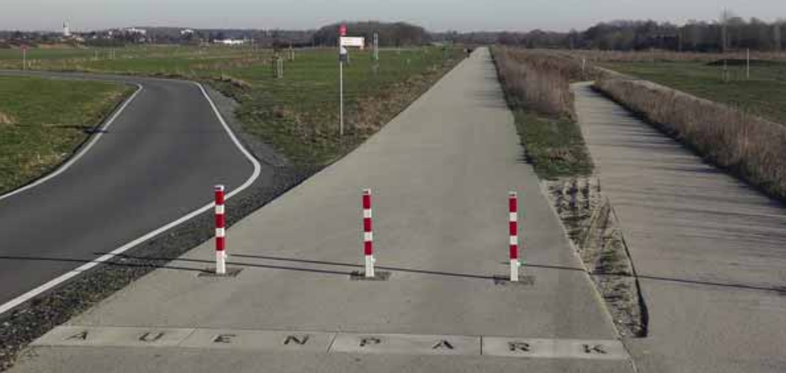
Diese drei Asphaltstraßen führen in den Erlebensraum, den „Auenpark“. Links des Weges liegt die fünf Hektar große Bodendeponie, die die Stadt Hamm „Hochplateau“ nennt. Ganz links die Hangars des Flugplatzes.
